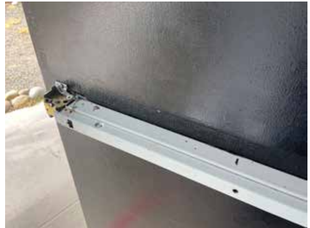
Replace door hardware
